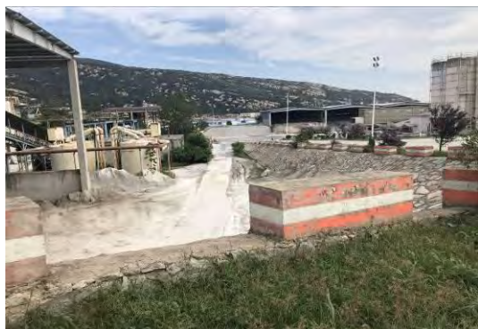
2018年3季度混凝土搅拌站挡墙及绿化
