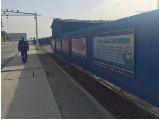
2016年2季度厂区彩钢板围挡临时措施
