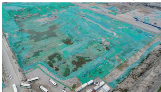
2020 年无临时堆渣区密目网苫盖
