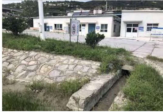
2018年3季度混凝土搅拌站绿化及挡墙
