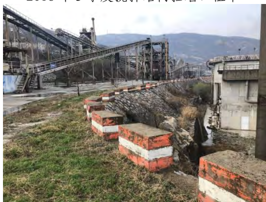
2019年搅拌站内挡墙、排水、绿化
