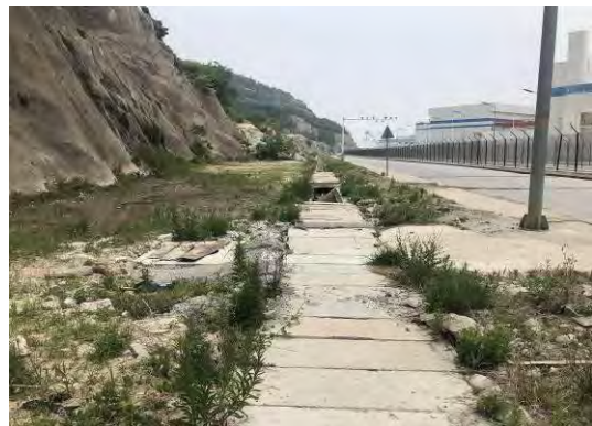
2019年混凝土边坡及排水沟
