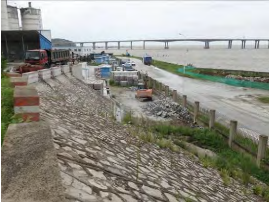
2017年3季度施工场地区护坡及绿化
