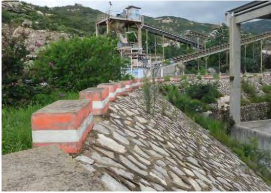
2017年3季度施工场地区浆砌石边坡、排水
