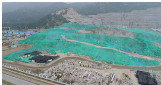
2019年2季度临时堆渣区密目网苫盖
