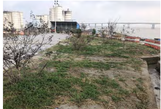
2019年搅拌站内挡墙、植草
