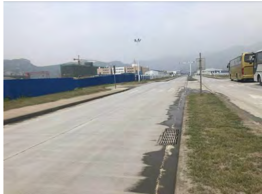
2019年BOP区植草、排水
