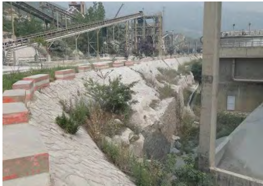
2017年2季度施工场地地区浆砌石边坡、排水
