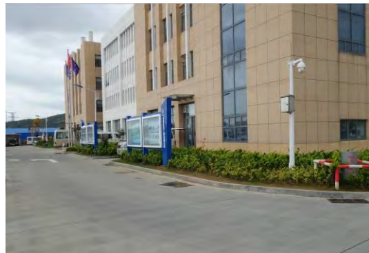
2017年3季度厂区办公楼围墙内绿化排水
