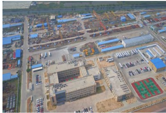
2016 年航拍施工现状
