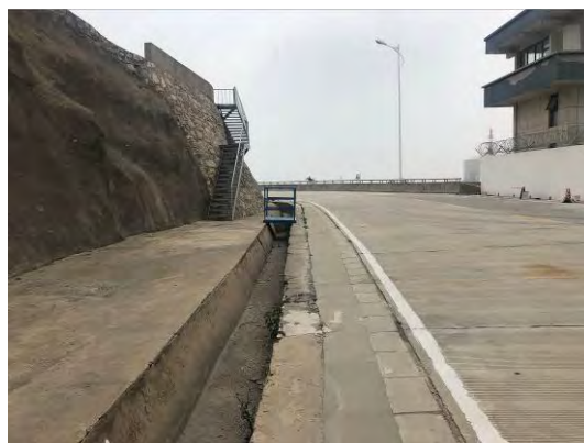
2019年混凝土边坡及排水沟
