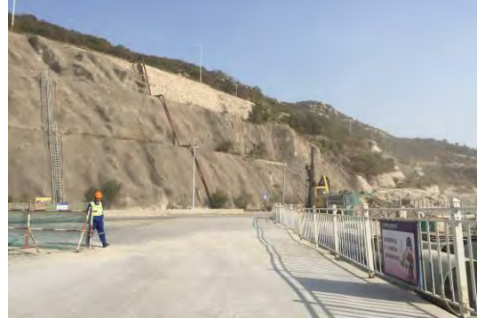
2017年4季度混凝土边坡、排水
