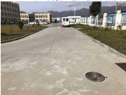
2018年4季度厂区 办公楼围墙内绿化排水
