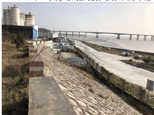
2018年4季度混凝土搅拌站挡墙及排水
