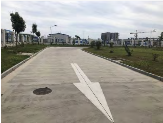
2018年3季度办公楼围墙内绿化排水
