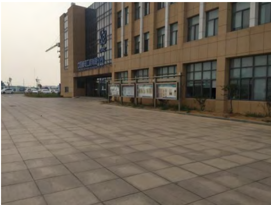
2016年3季度办公楼围墙内绿化排水
