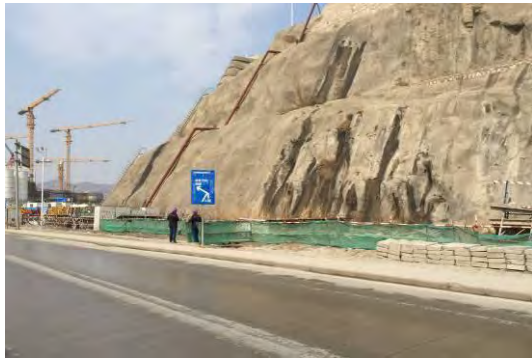
2017年1季度混凝土边坡、排水
