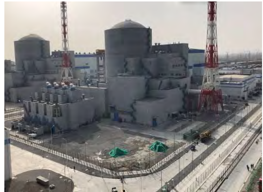
2018年4季度厂区34机组施工现状
