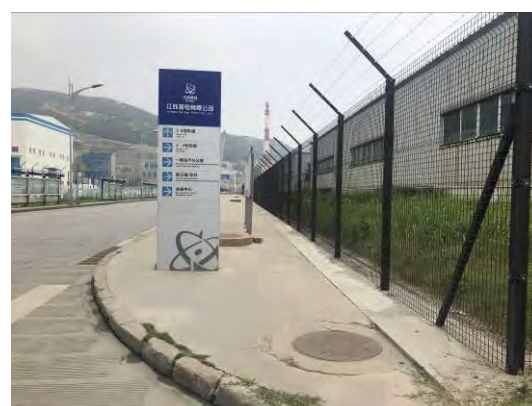
2019 年厂区道路排水及两侧植草
