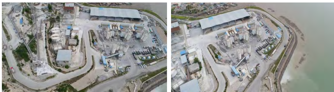
2018年2季度无人机拍到的施工场地区（搅拌站及砂石料场）绿化及边坡防护
