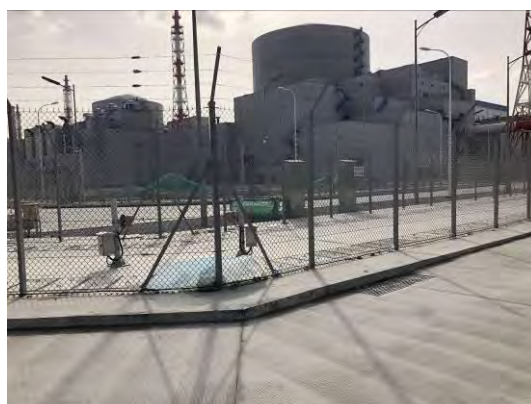
2018年4季度厂区34机组施工现状
