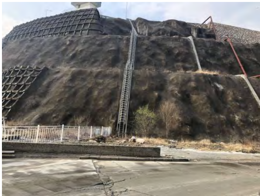
2019 年混凝土边坡及排水沟
