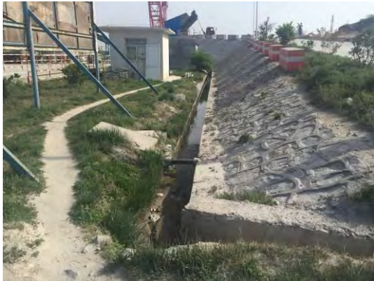
2016年2季度混凝土搅拌站挡墙及排水
