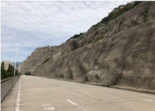
2018年3季度厂区34机组混凝土边坡
