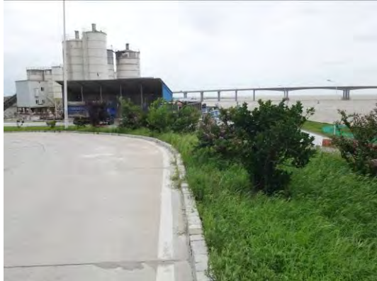
2017年3季度施工场地区护坡及绿化
