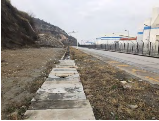
2019 年混凝土边坡及排水沟
