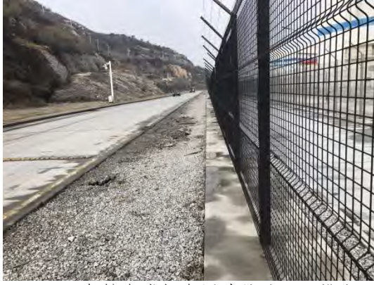
2019年核岛常规岛周边铺碎石、排水
