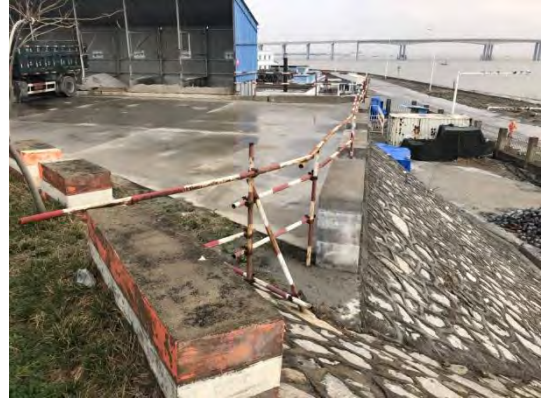
2019年搅拌站内挡墙、排水、绿化
