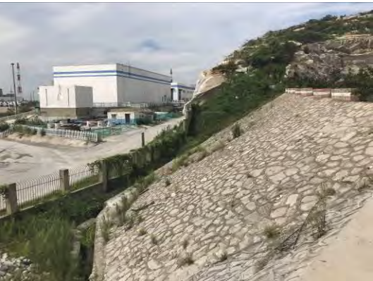
2018年3季度混凝土搅拌站挡墙及排水
