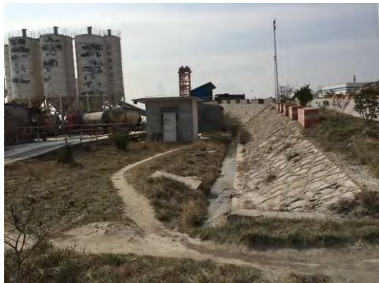
2017年1季度混凝土搅拌站绿化及挡墙
