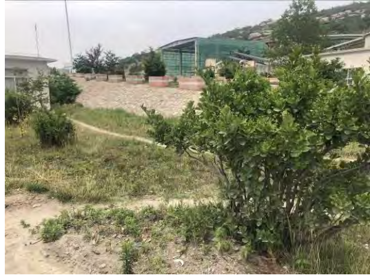
2019年搅拌站内挡墙、植草
