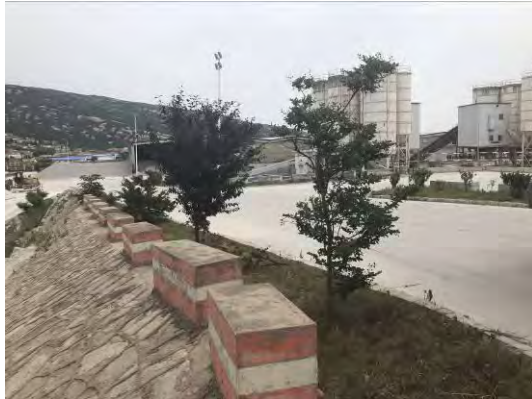
2018年2季度混凝土搅拌站挡墙及绿化
