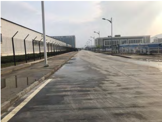
2019年BOP区植草、排水
