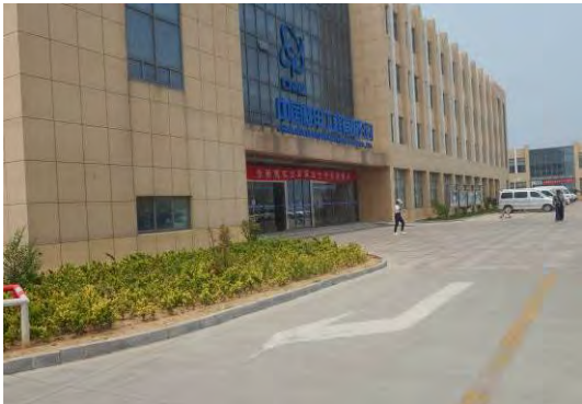
2017年2季度厂区办公楼围墙内绿化排水
