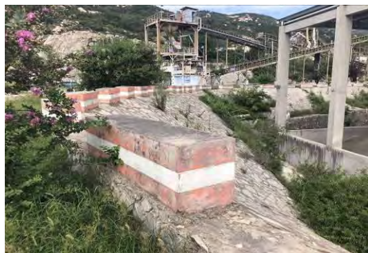
2018年3季度混凝土搅拌站挡墙及绿化
