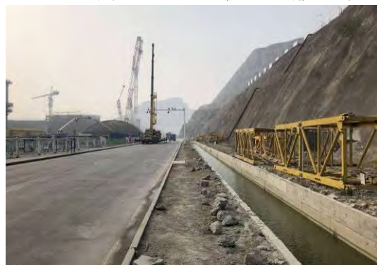
2018年1季度混凝土边坡、排水
