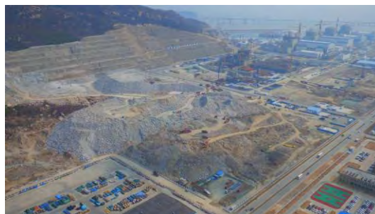
2017 年无人机拍到临时堆渣场照片
