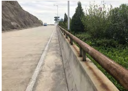
2018年3季度厂区34机组混凝土边坡
