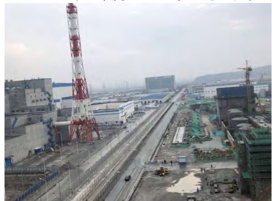
2019年核岛常规岛铺碎石、排水
