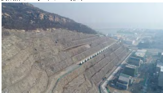
2019年4季度无人机拍照边坡防护及平台绿化
