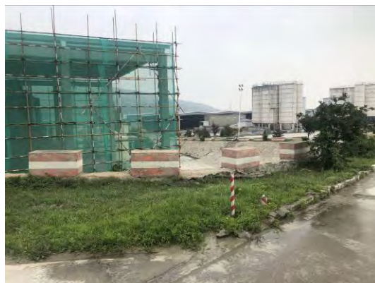
2019年搅拌站内挡墙、排水、绿化
