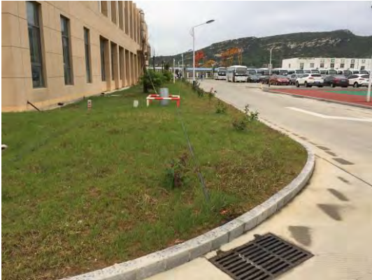
2017年3季度办公楼围墙内绿化排水
