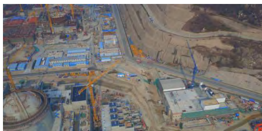
2017 年人工边坡区护坡、绿化及厂区施工现状
