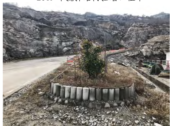
2019年搅拌站内挡墙、排水、绿化
