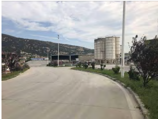
2018年3季度混凝土搅拌站道路两侧绿化
