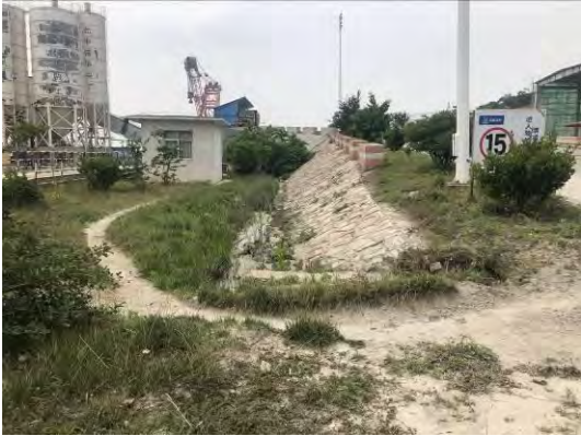
2019年搅拌站内挡墙、植草
