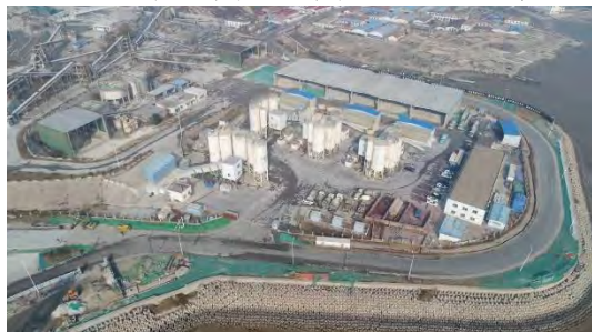
2019年4季度无人机拍照混凝土搅拌站浆砌石护坡、绿化、排水
