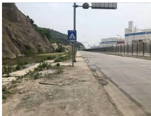
2019年混凝土边坡及排水沟
