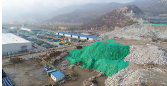
2019年1季度34号碎石、排水及密目网围挡 2019年1季度临时堆渣区密目网苫盖
