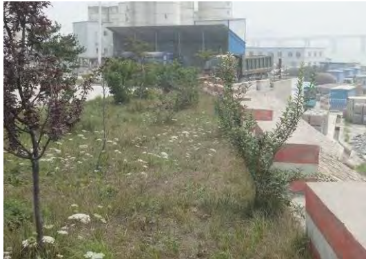
2017年2季度施工场地地区护坡及绿化
