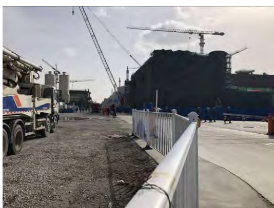
2018 年道路两侧铺碎石
