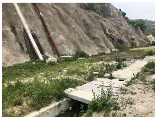
2019年混凝土边坡及排水沟
