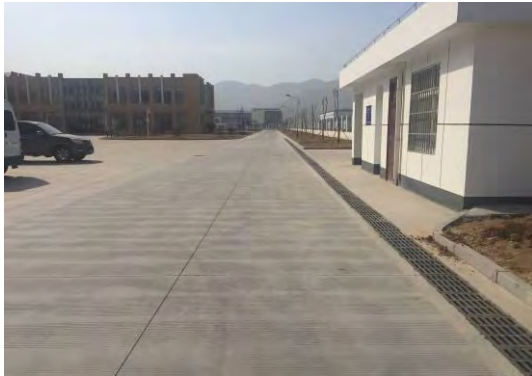
2016年2季度办公楼围墙内绿化排水
