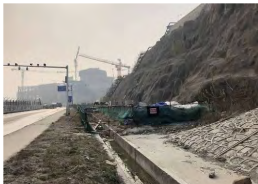
2018年2季度混凝土边坡、排水
