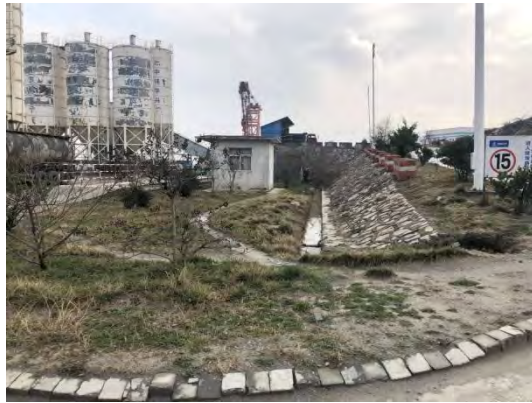
2019年搅拌站内挡墙、植草
