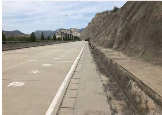
2018年3季度3季度厂区34机组混凝土边坡
