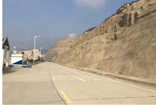
2017年2季度混凝土边坡及排水
