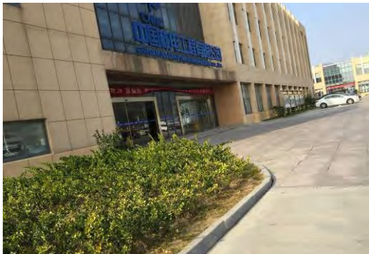
2017年4季度厂区办公楼围墙内绿化排水
