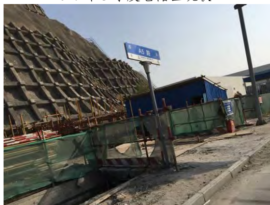
2017年4季度施工物料存放点
