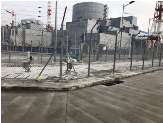
2019年核岛常规岛铺碎石、排水
