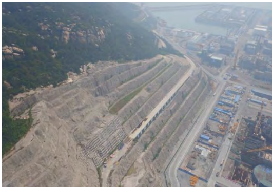
2016 年航拍人工边坡区护坡及绿化
