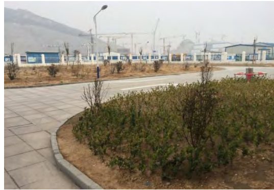
2016年4季度办公楼围墙内绿化排水
