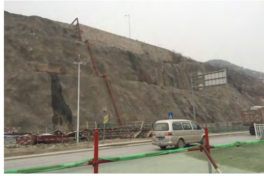
2016年4季度混凝土边坡、排水
