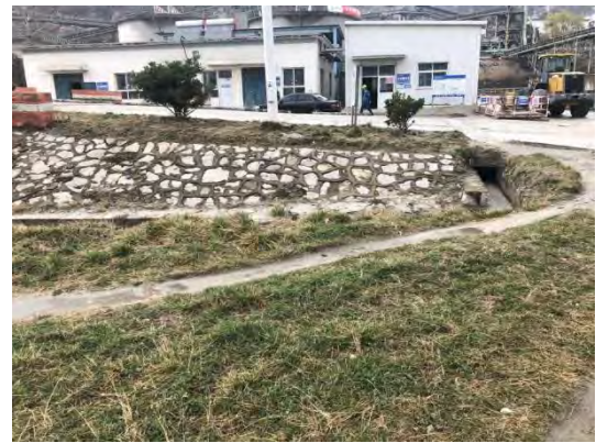
2019年搅拌站内挡墙、植草
