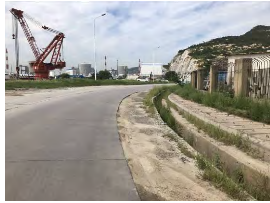
2018年3季度混凝土搅拌站站外排水
