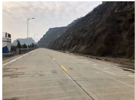
2019 年混凝土边坡及排水沟
