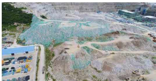
2018年3季度无人机拍到临时堆渣场密目网苫盖照片
