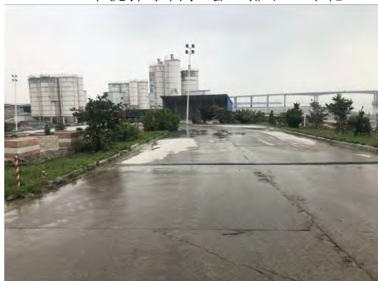
2019年搅拌站内挡墙、排水、绿化 8) 施工场地 (临时堆渣区)
