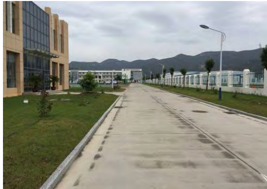
2017年3季度办公楼围墙内绿化排水
