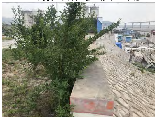
2019年搅拌站内挡墙、排水、绿化
