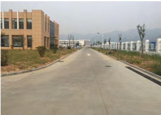
2016年3季度办公楼围墙内绿化排水
