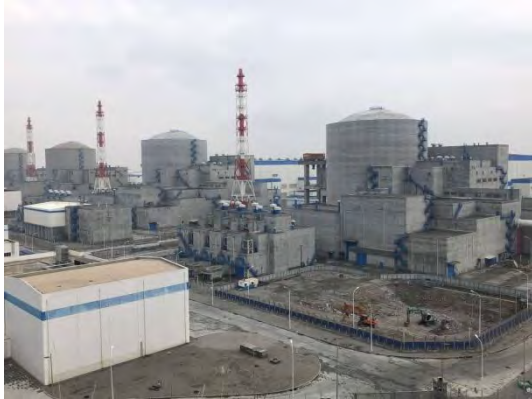
2019年核岛常规岛铺碎石、排水
