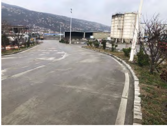
2019年搅拌站内挡墙、排水、绿化
