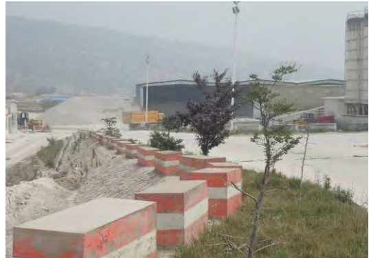
2017年2季度施工场地地区护坡及绿化
