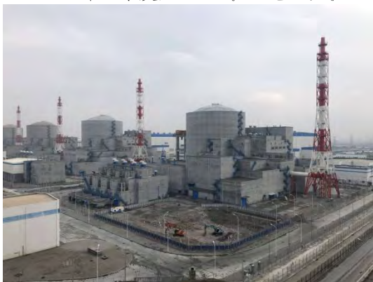
2019年核岛常规岛铺碎石、排水
