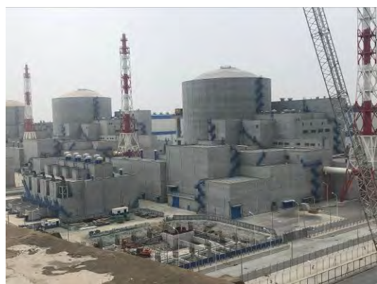
2019 年施工场地铺碎石、排水
