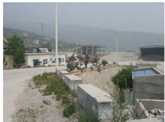
2017年2季度施工场地地区浆砌石边坡、排水
