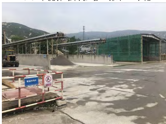
2019年搅拌站内挡墙、排水、绿化
