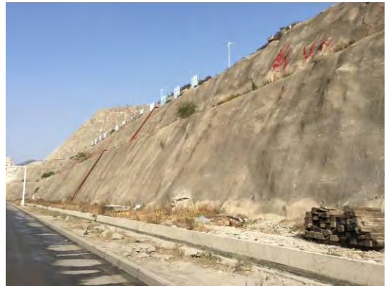
2017 年 4 季度混凝土边坡及排水
