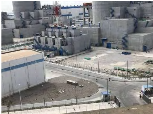
2018年3季度厂区34机组施工现状
