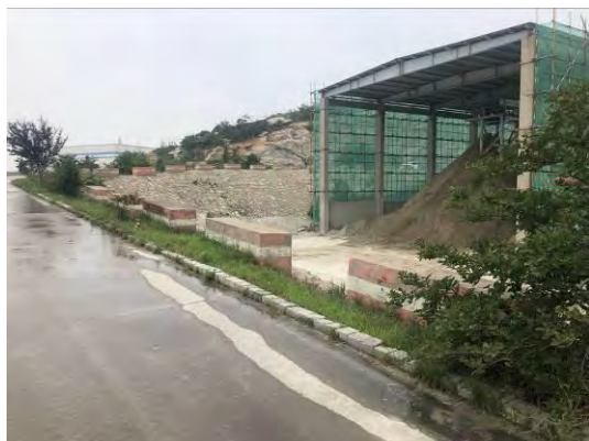
2019年搅拌站内挡墙、排水、绿化
