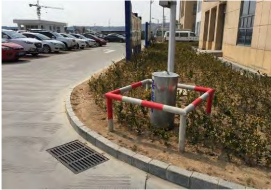
2017年1季度厂区办公楼围墙内绿化排水
