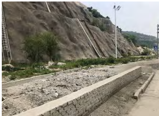
2019年混凝土边坡及排水沟
