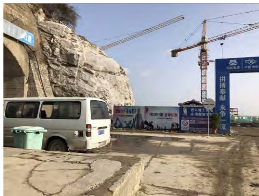
2018年34号机组取水头部边坡拆除
