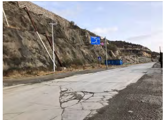
2019 年混凝土边坡及排水沟
