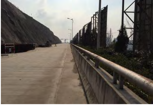
2017年1季度混凝土边坡及绿化
