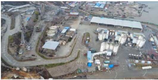
2019年无人机拍照混凝土搅拌站浆砌石护坡、绿化、排水
