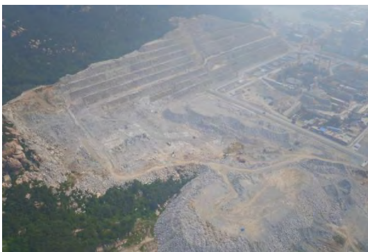
2016 年 3 季度航拍边坡及临时堆渣场
