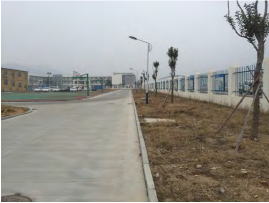
2016年4季度办公楼围墙内绿化排水
