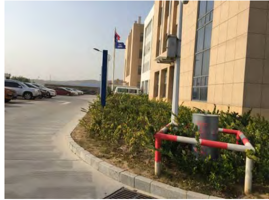
2017年4季度办公楼围墙内绿化排水
