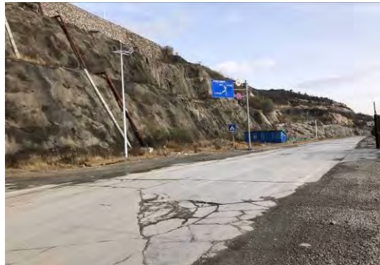
2018年4季度厂区34机组混凝土边坡
