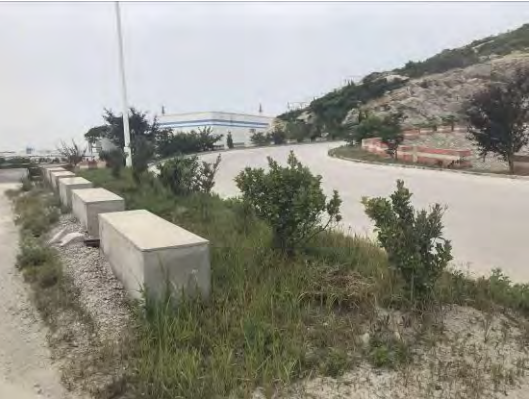
2018年2季度混凝土搅拌站挡墙及绿化
