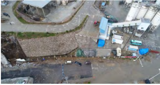
2019年1季度混凝土搅拌站浆砌石护坡、绿化、排水
