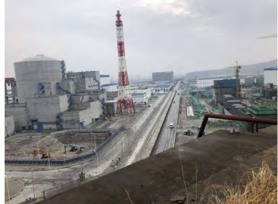
2019年核岛常规岛铺碎石、排水
