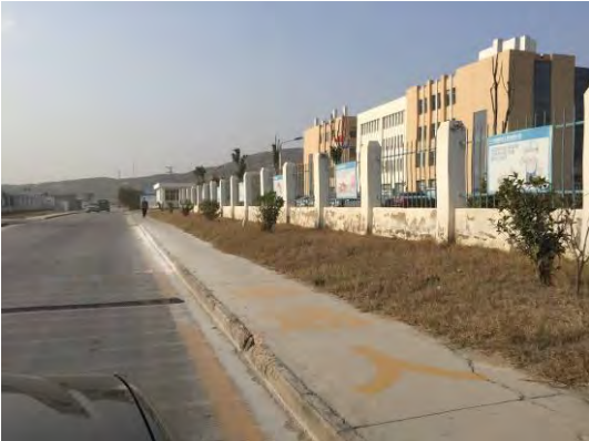
2017年3季度办公楼围墙外绿化排水
