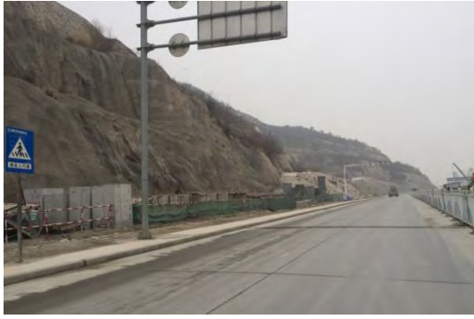
2016年3季度混凝土边坡、排水
