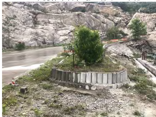
2019年搅拌站内挡墙、排水、绿化
