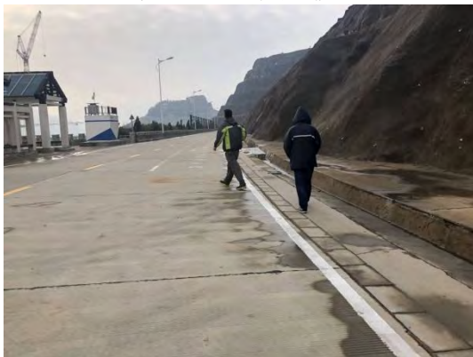
2019 年混凝土边坡及排水沟
