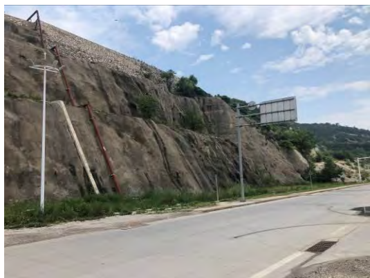
2020 年浆砌石边坡及排水
