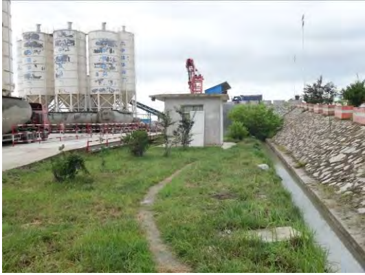
2017年3季度混凝土搅拌站挡墙及排水
