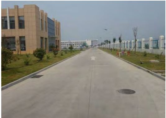
2017年2季度办公楼围墙内绿化排水
