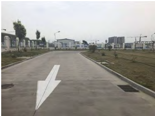
2018年2季度办公楼围墙内绿化排水
