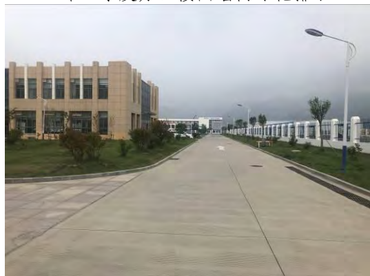
2019年厂区 办公楼围墙内绿化排水
