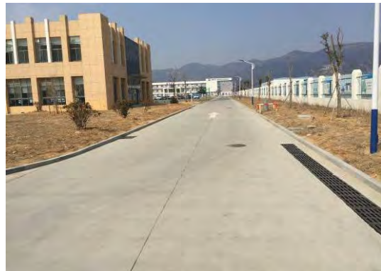
2017年1季度办公楼围墙内绿化排水
