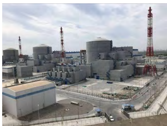
2018 年 3 季度厂区 34 机组施工现状
