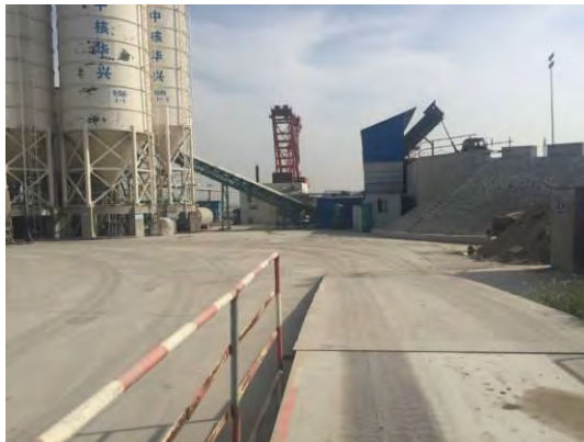
2016年2季度混凝土搅拌站施工场地
