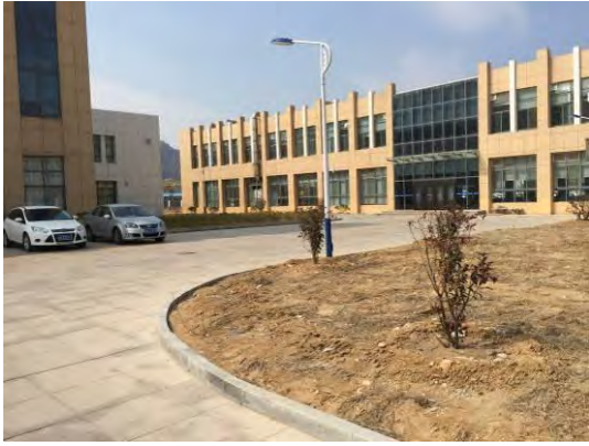
2017年1季度办公楼围墙内绿化排水
