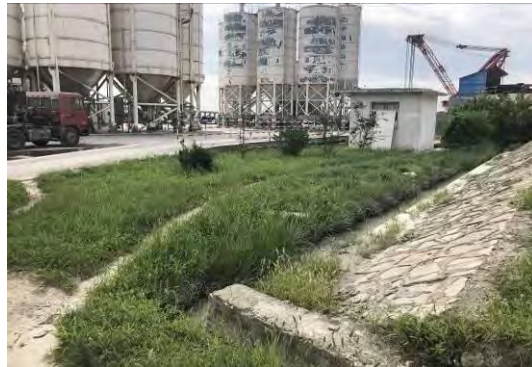
2018年3季度搅拌站内挡墙、植草
