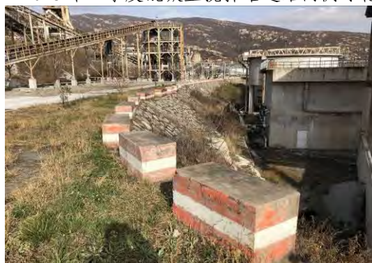
2018年4季度混凝土搅拌站挡墙及绿化
