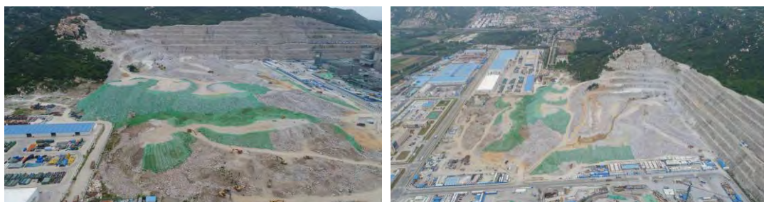
2018年2季度无人机拍到临时堆渣场密目网苫盖照片
