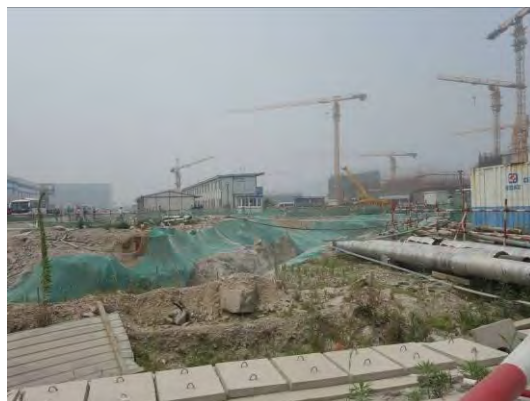
2017年2季度施工密目网苫盖
