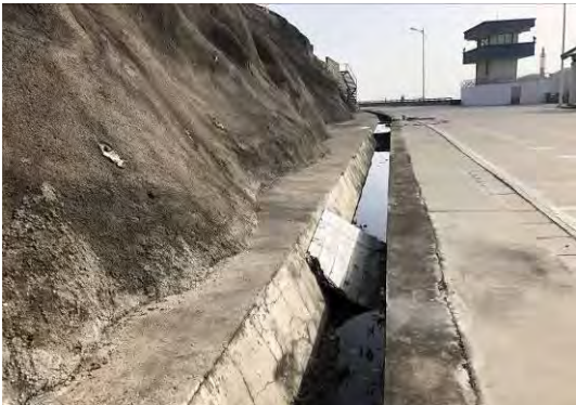
2018年4季度厂区34机组混凝土边坡及排水
