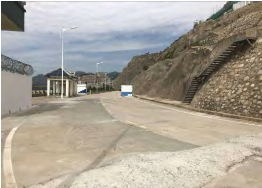
2018年3季度厂区34机组混凝土边坡
