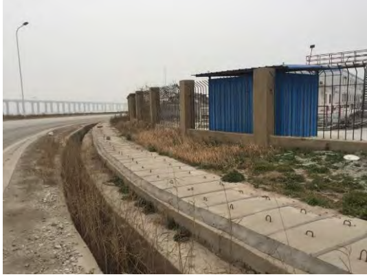
2017年4季度混凝土搅拌站外排水
