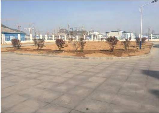
2016年1季度办公楼围墙内绿化排水
