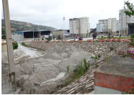
2017年3季度施工场地区浆砌石边坡防护
