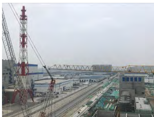
2019 年施工场地铺碎石、排水
