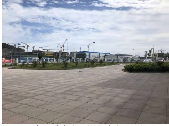
2018年3季度办公楼围墙内绿化排水
