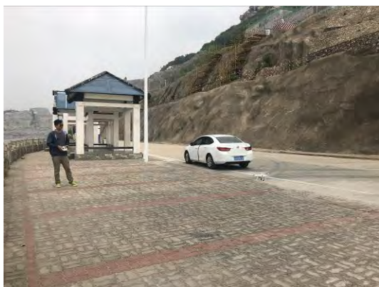
2019年混凝土边坡及排水沟 16) 取排水区(植草)
