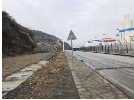
2019 年混凝土边坡及排水沟
