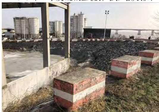
2018年4季度混凝土搅拌站挡墙及绿化
