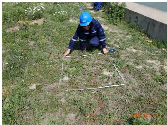
2016年2季度施工区部分平整后植被恢复
