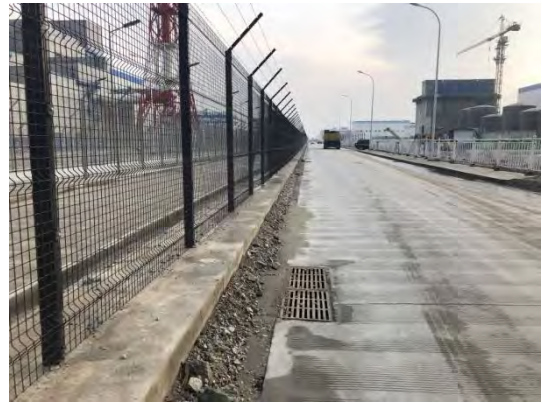
2019年核岛常规岛铺碎石、排水
