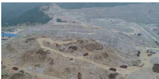
2017 年 2 季度无人机拍到临时堆渣场照片
