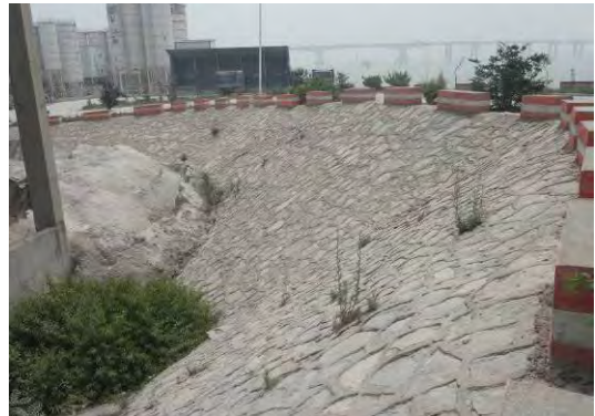
2017年2季度施工场地地区浆砌石边坡防护
