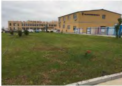
厂区绿化排水措施
