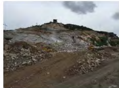
取水隧洞施工现状
