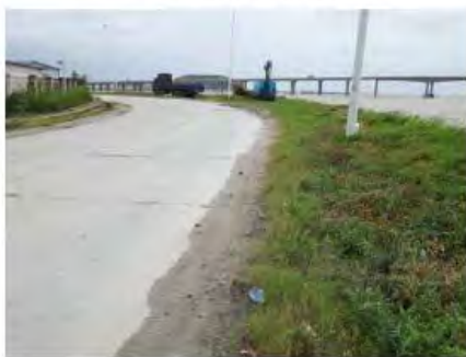
施工场地区外排水
