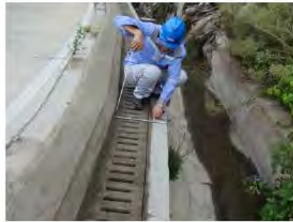
人工边坡平台排水
