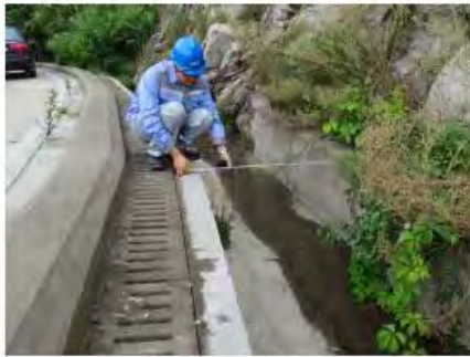
人工边坡平台排水
