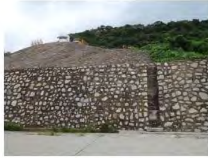
厂区浆砌石挡墙
