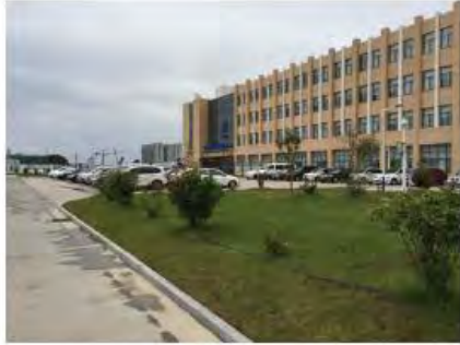
厂区绿化排水措施
