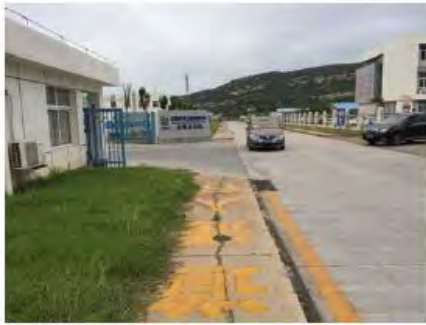
厂区绿化排水措施
