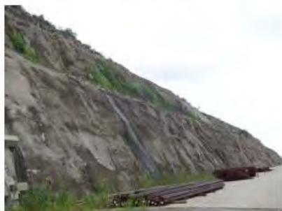
厂区边坡平台混凝土护坡及绿化
