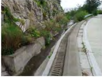
人工边坡平台排水
