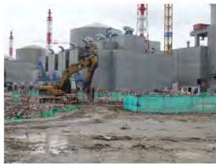
厂区施工密目网苫盖
