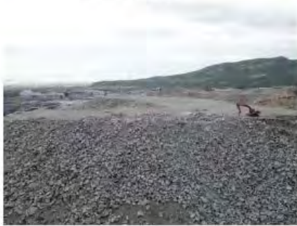
临时堆渣场（在开挖边坡区）
