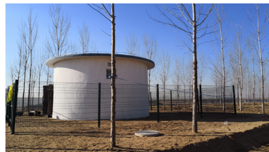
辽宁核电水源地改造施工
