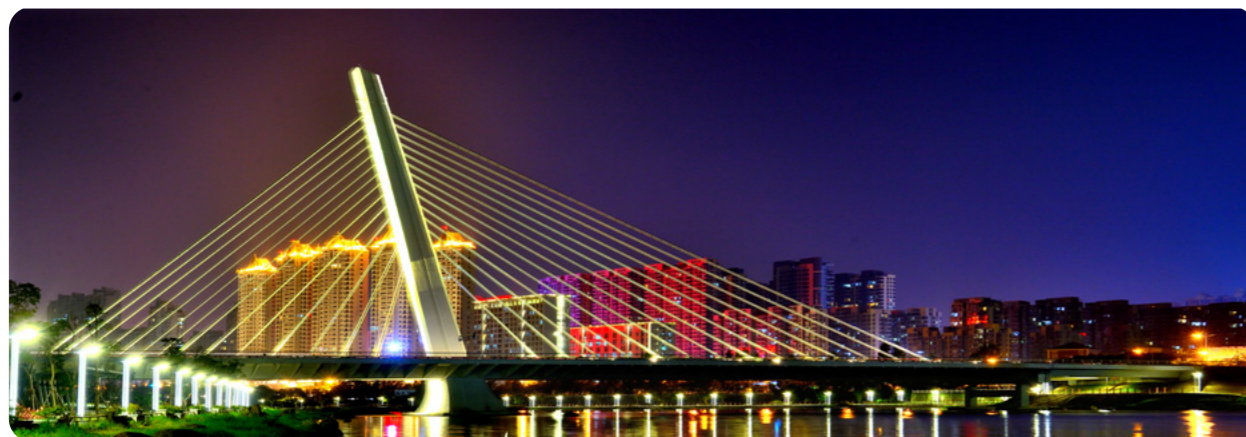
福清核电与地方共建的福清市观音浦大桥
