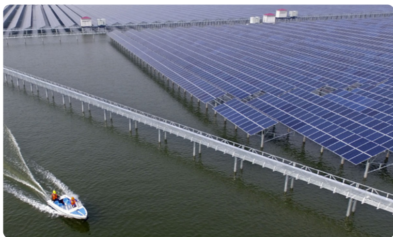
中核汇能沧州南大港渔光互补项目
